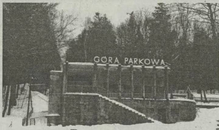
Dolna stacja kolejki na Parkowej Górze. Fot. J. P. Kazubowski
